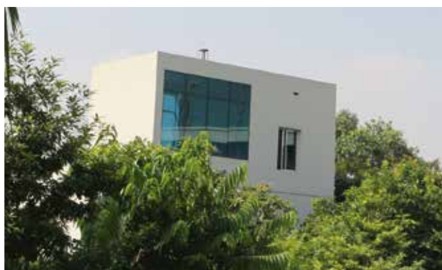
Effluent Treatment Plant (ETP)
